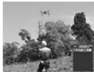
UAVによる空中写真測量▶P.7
